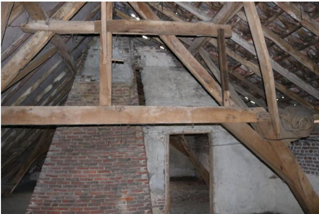
Vleugel 1 : dakgebinte met 17 de en 18 de eeuwse elementen
