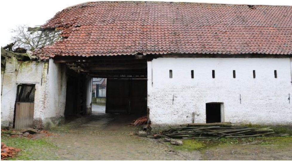
Vleugel 3 : zicht vanaf de binnenplaats
