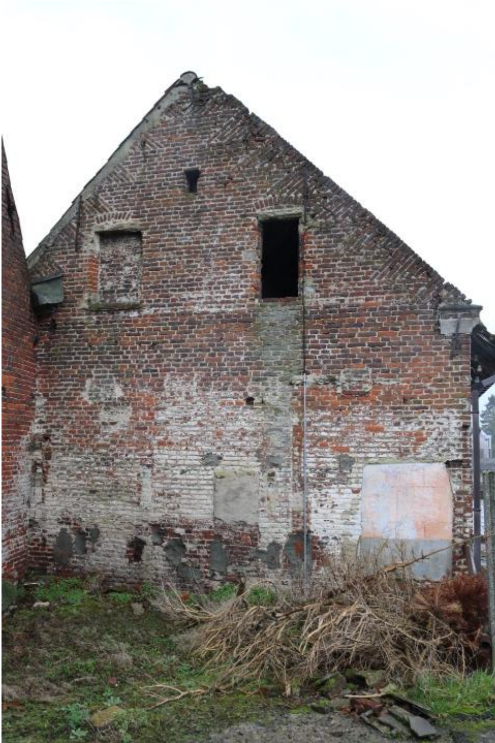
Vleugel 1 : boerenwoning noordelijk zijgevel. Diverse oudere (17 de eeuw?) raamopeningen en vlechting
