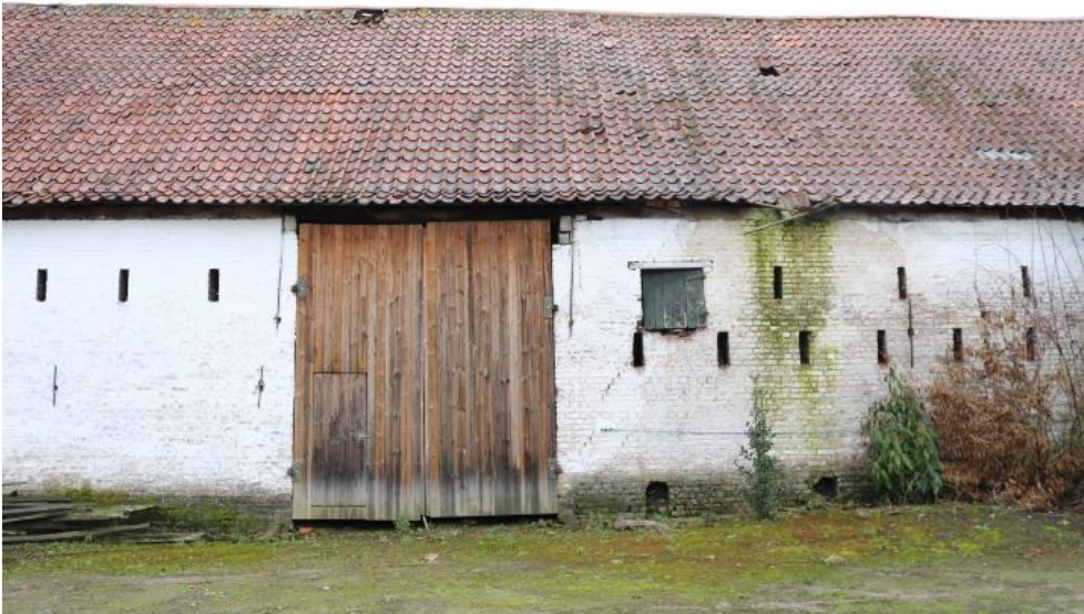
Vleugel 3 : zicht vanaf de binnenplaats
