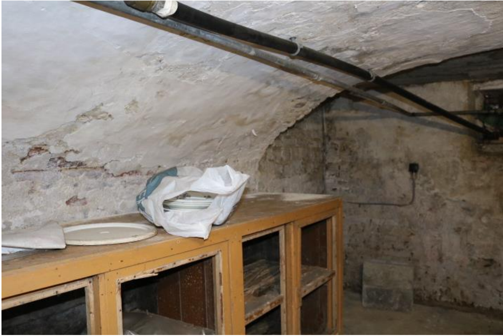
Vleugel 1 : bakstenen kelder met tongewelf
