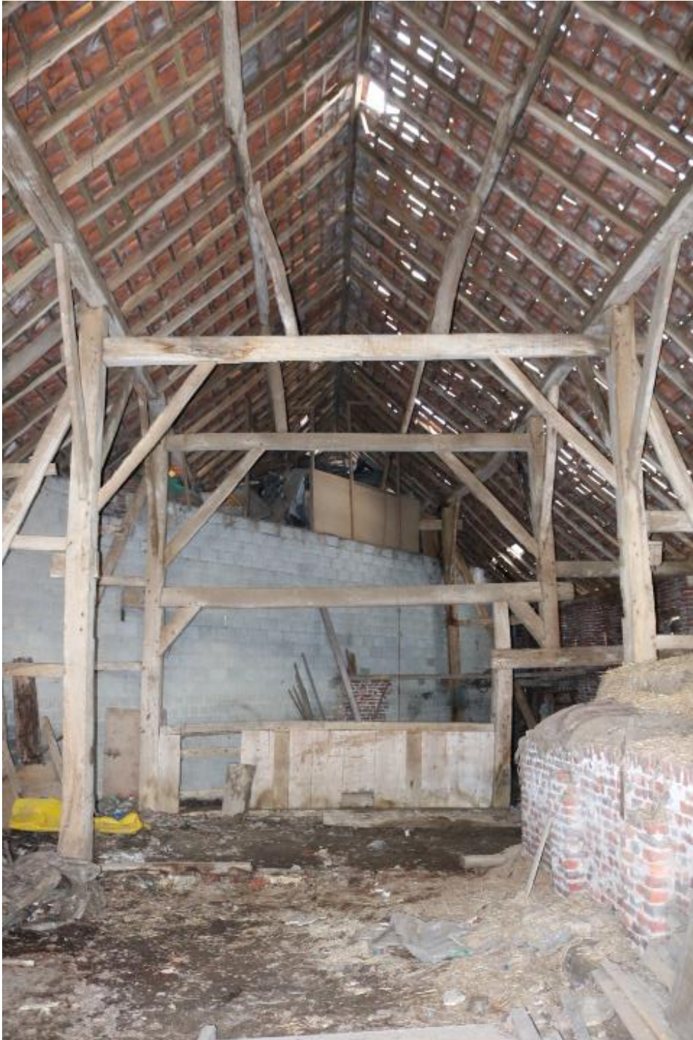
Vleugel 3 : zicht op 19 de of 20 ste eeuwse dakgebinte. Achteraan muur in snelbouw van een recente constructie.
