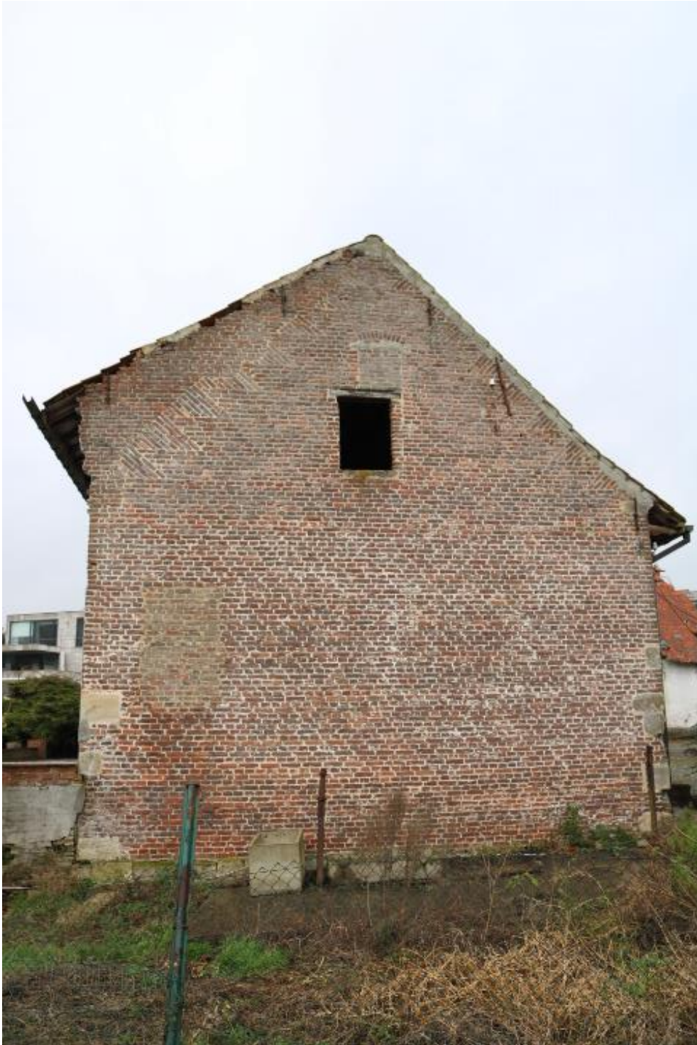
Vleugel 1 : boerenwoning zuidwestelijke zijgevel met spolia uit zandsteen in fundering; negblokken in zandsteen op de hoeken; vermoedelijk 17 de eeus metselwerk in kruisverband: oorspronkelijke vensteropeningen met spaarboog in baksteen; vlechting
