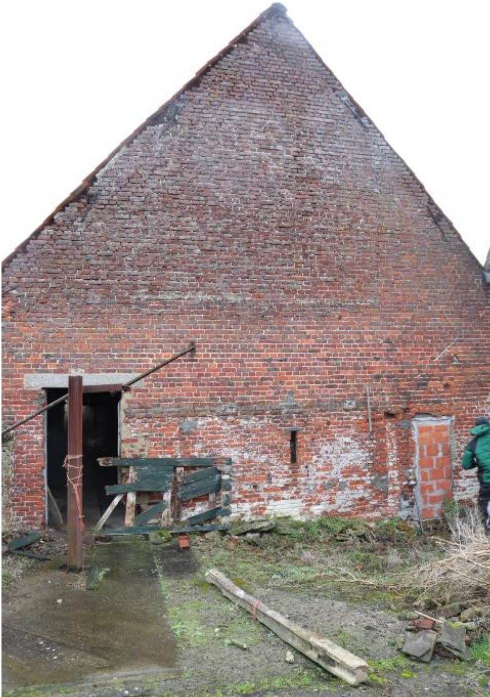
Vleugel 2 : zuidelijke zijgevel. In de onderste bouwlagen werd baksteenformaat 1 vastgesteld in kruisverband
