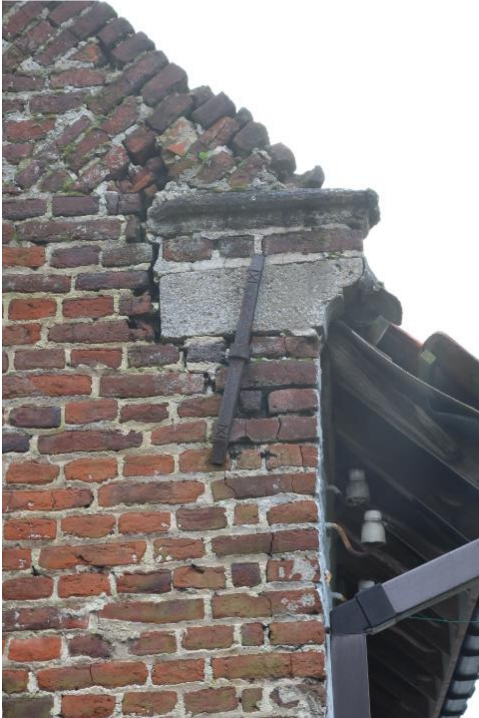
Vleugel 1 : boerenwoning noordelijk zijgevel. Oudere geprofileerde negblokken uit zandsteen (17 de eeuw?)
