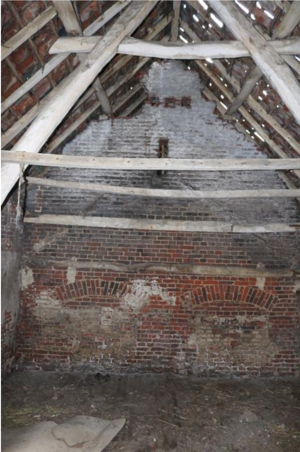
Vleugel 4 : zicht interieur zuidelijk deel van de bedrijfsvleugel. Vermoedelijk 19 de eeuwse tussenmuur. De muuropeningen wijzen op de aanwezigheid van bakovens in de aanpalende ruimte
