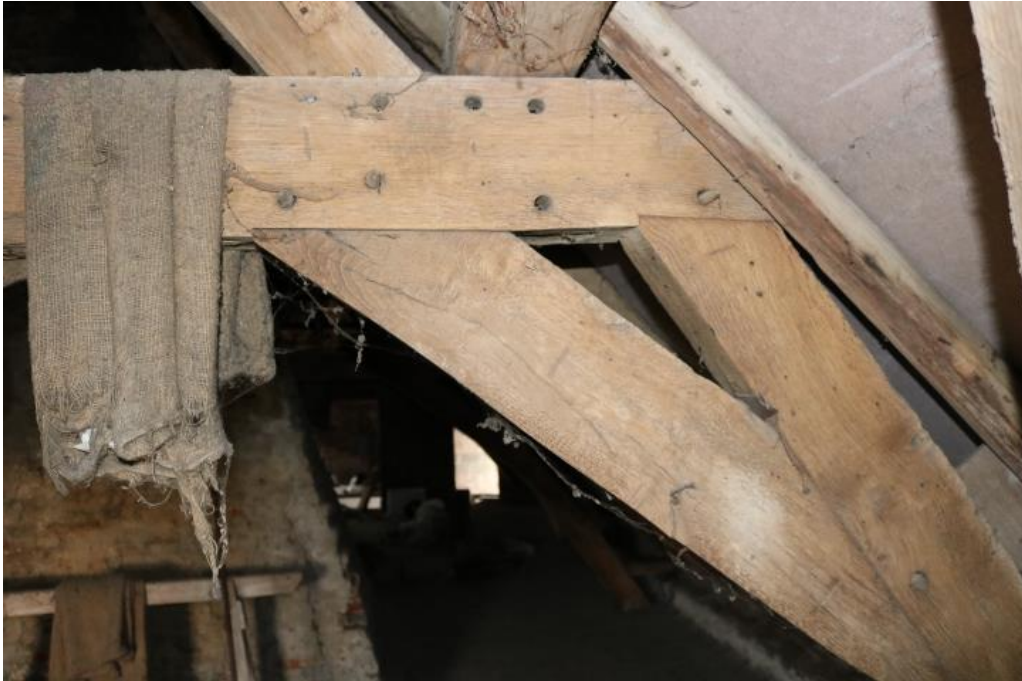
Vleugel 1 : dakgebinte met 17 de en 18 de eeuwse elementen. Voorbeeld van schrijnwerkersmerken (I)
