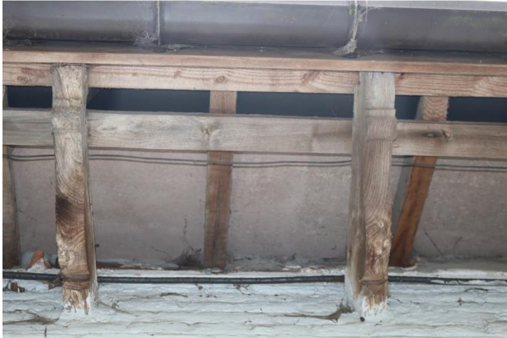
Vleugel 1 : boerenwoning. 18 de eeuwse houten klossen aan de voorgevel
