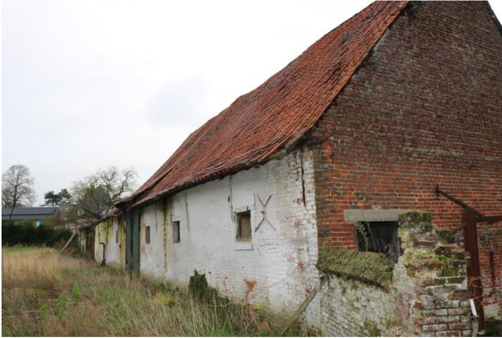
Vleugel 2 : achtergevel en zuidelijke zijgevel. Vermoedelijke grotendeels 18 de en 19 de eeuws. Op de hoek van de achtergevel en zuidelijke zijgevel werd in de onderste bouwlagen baksteenformaat 1 vastgesteld in kruisverband
