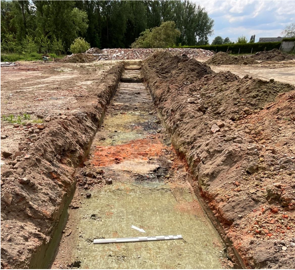
Figuur 20. Puinlaag S13
