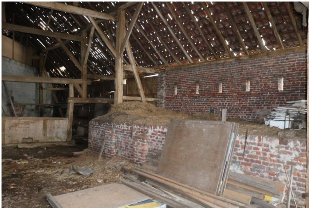
Vleugel 3 : metselwerk in baksteenformaat 3. Achteraan muur in snelbouw van een recente constructie.
