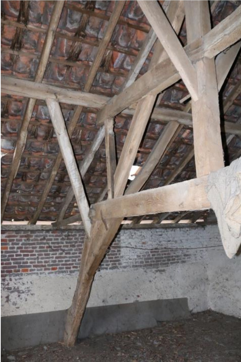
Vleugel 1 : dakgebinte met 17 de en 18 de eeuwse elementen
