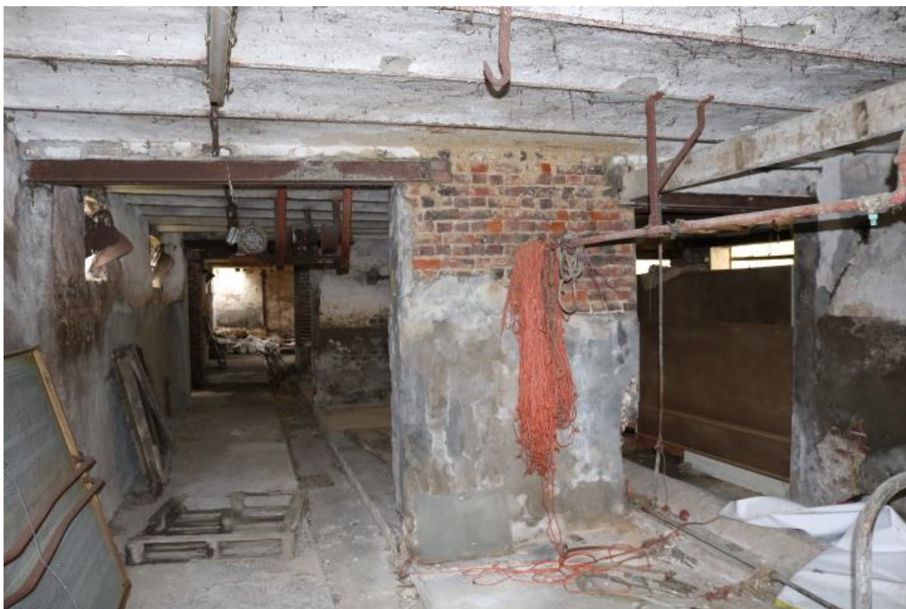
Vleugel 2 : inrichting als stallen. Inrichting na de 19 de eeuw gezien de bakstenen gewelven op stalen I-profiel.
