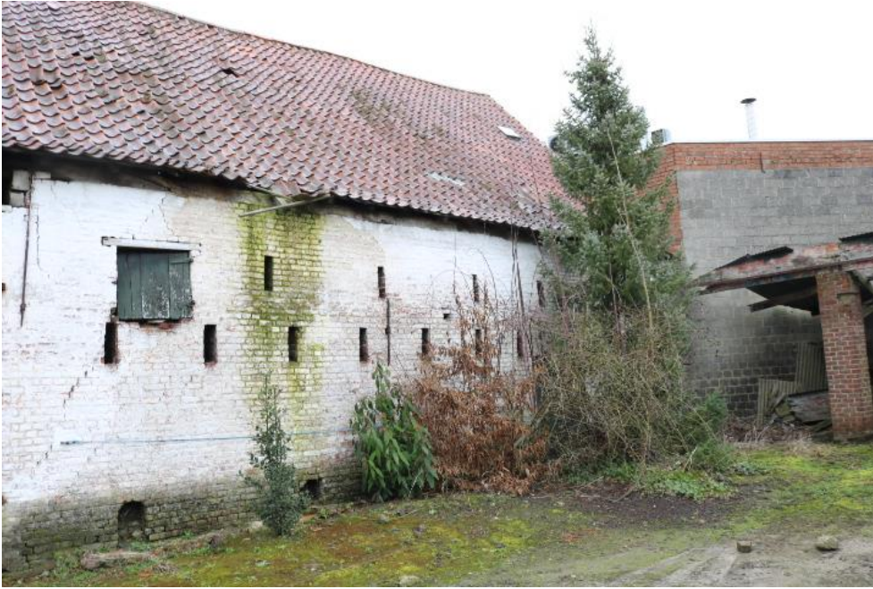
Vleugel 3 : zicht vanaf de binnenplaats
