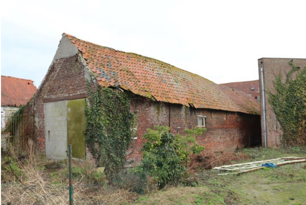
Vleugel 4 : achtergevel en zuidelijke zijgevel. In de onderste bouwlagen werd baksteenformaat 1 vastgesteld in kruisverband
