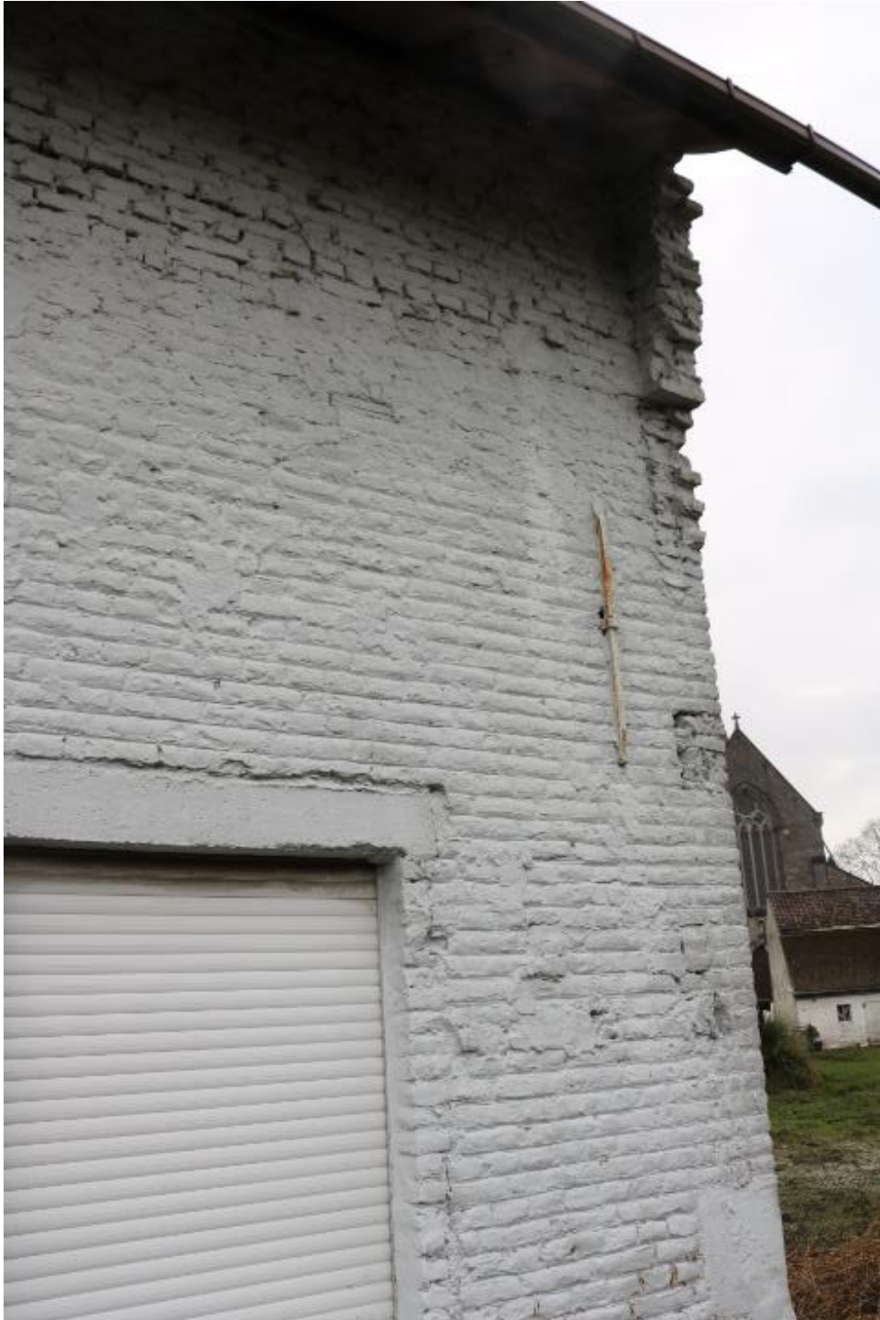
Vleugel 1 : boerenwoning achtergevel. Detail van afbraaksporen aan de zuidelijke hoek
