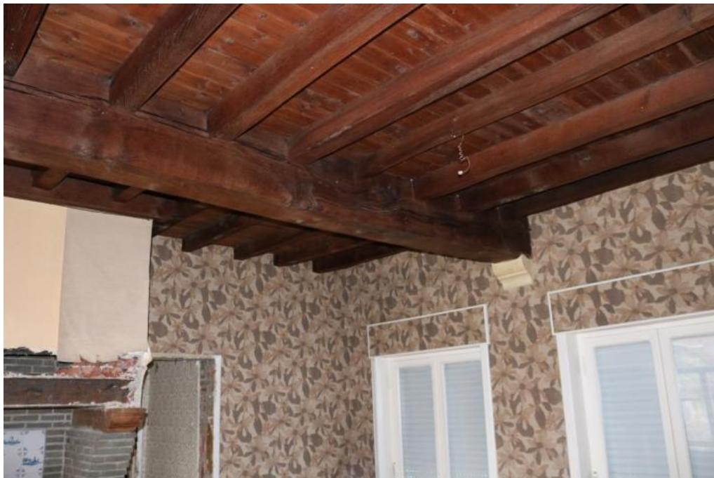
Vleugel 1 : houten plafondconstructie. Mogelijk te dateren in de 17 de eeuw. Geprofileerde consoles dragen de constructie van moer- en kinderbalken.
