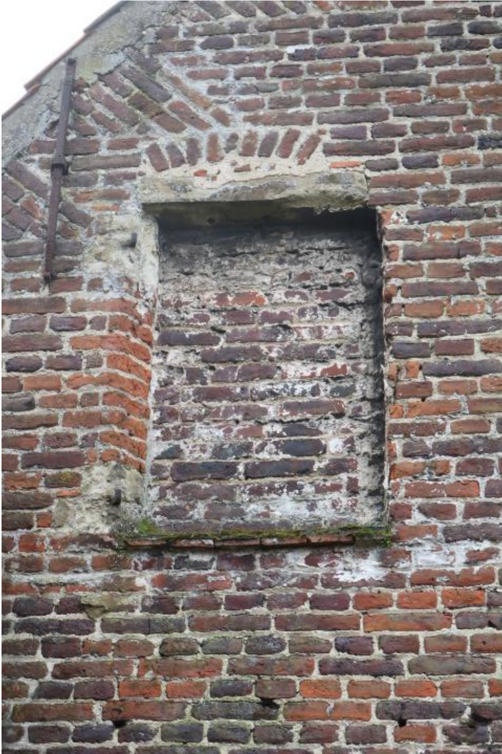
Vleugel 1 : boerenwoning noordelijk zijgevel. Oudere (17 de eeuw?) raamopening met linteel uit zandsteen en spaarboog uit baksteen; vlechting; 18 de of 19 de eeus gevelanker
