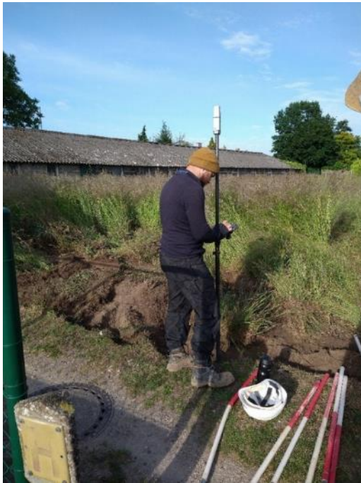
Figuur 36: landmeetkundige opmetingen uitgevoerd door middel van een DGPS (model Sokkia GCX2 ).
