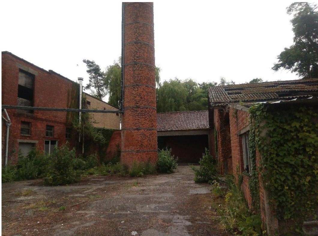
Figuur 5: Zicht op de bestaande bebouwing met centraal een schouw
