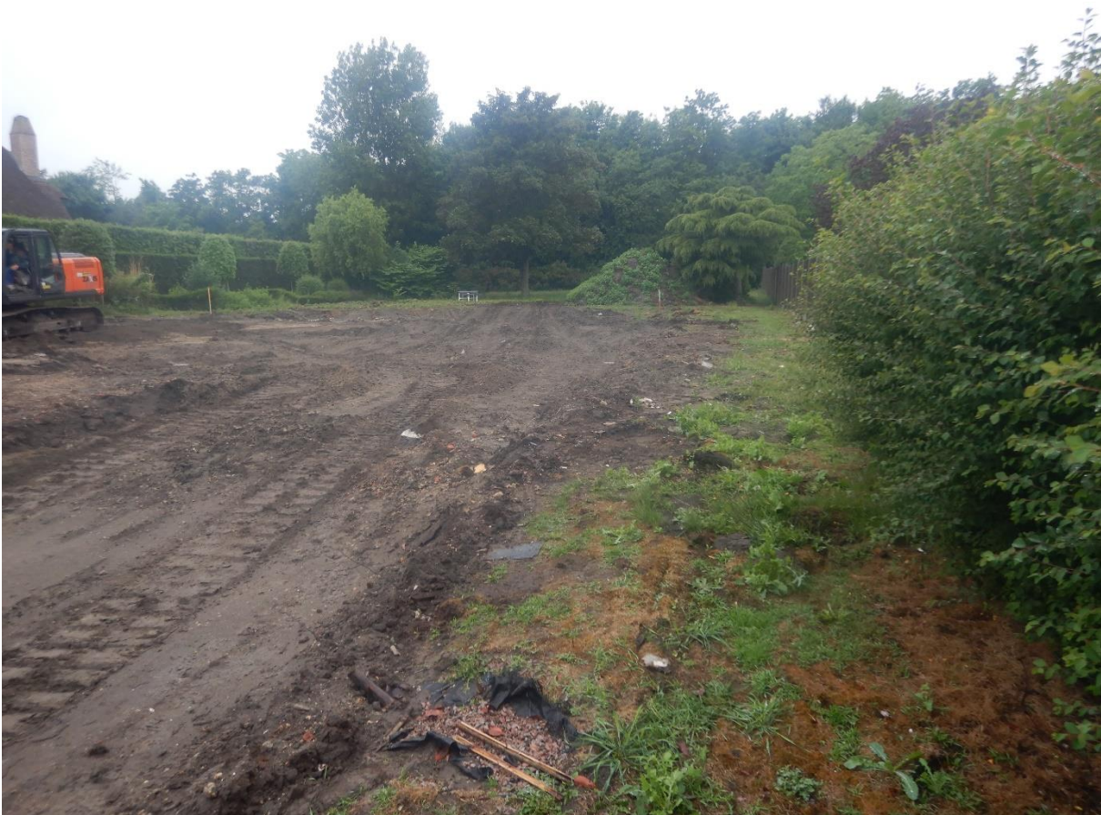
Figuur 7. Zicht op het terrein voor aanvang van de werken.
