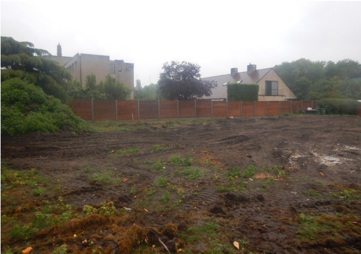
Figuur 6. Zicht op het terrein voor aanvang van de werken.
