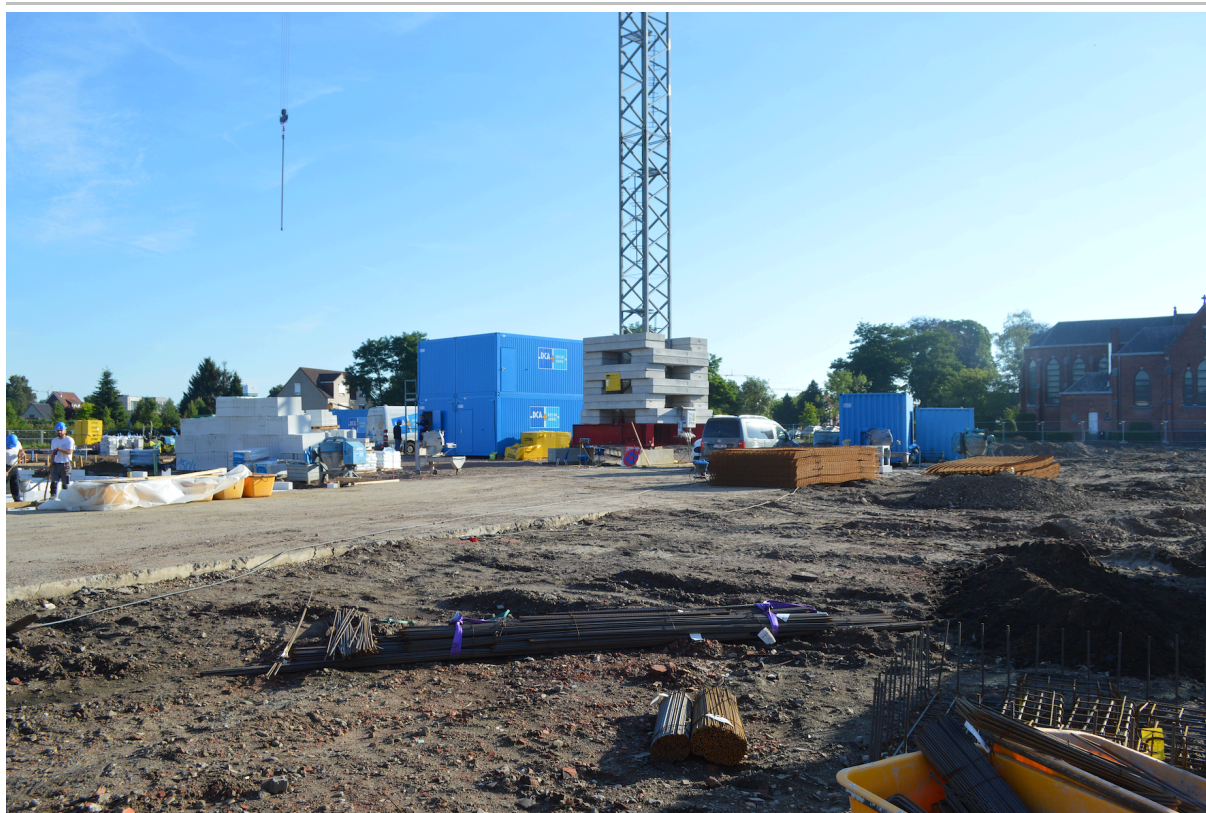
Fig. 2.6: Zicht op de verharde werfingang- en inrichting binnen het projectgebied.
