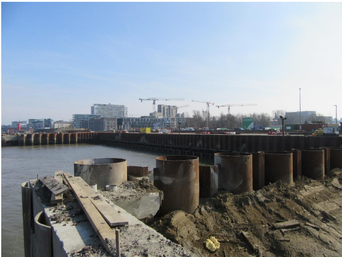
Figuur 19: Foto's van de aanleg van de bouwkuipen
