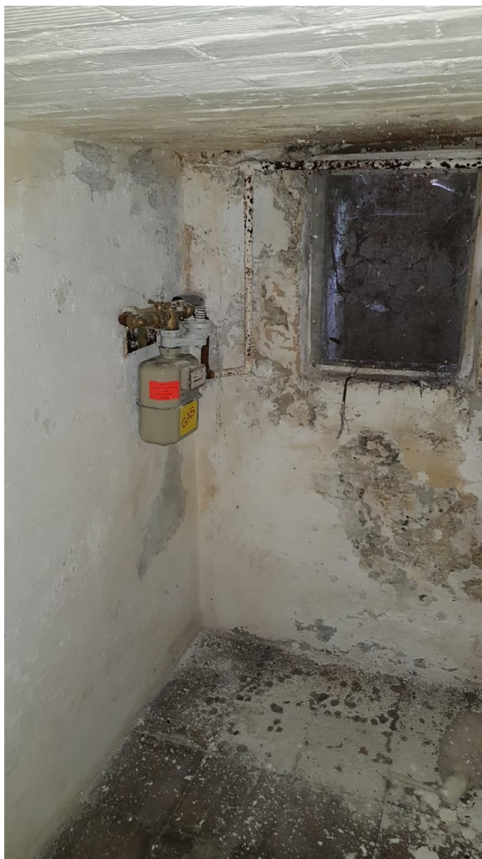
Figuur 10: Zicht op de kelder. 17
