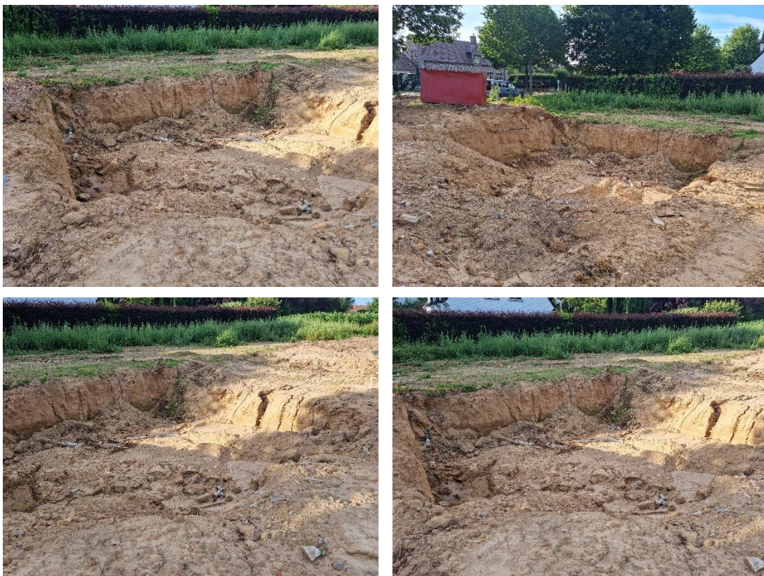
Fig. 4: de kelderput van huisnummer 7a
