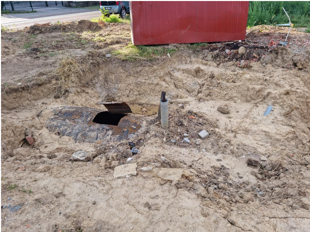
Fig. 5: de ondergrondse mazouttank aan huisnummer 7a
