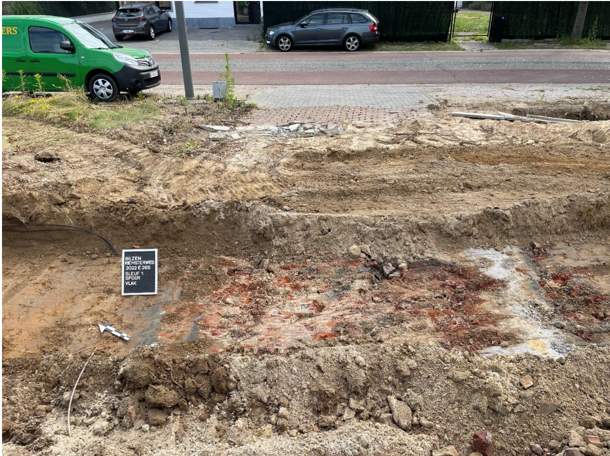
Fig. 11: De funderingslaag van de inrit naar huisnummer 7a, proefsleuf 1
