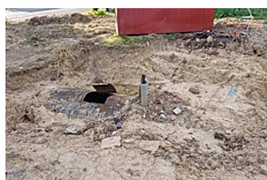
2022E265 kelder 7a mazouttank
