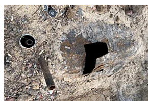
2022E265 kelder 7a mazouttank
