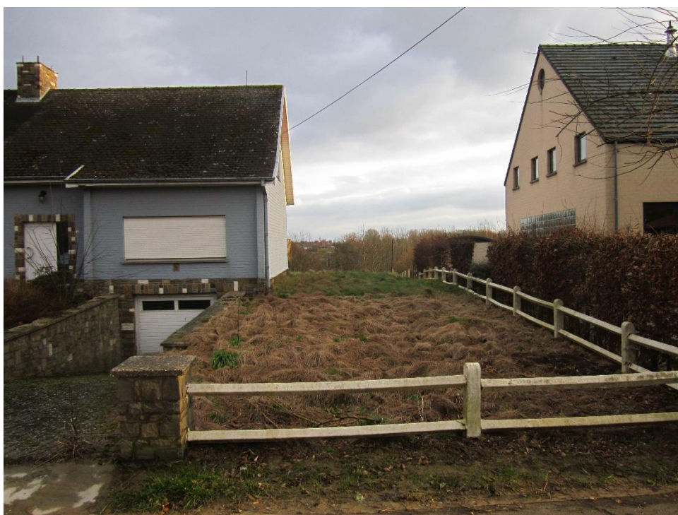
Figuur 6: Foto met zicht op J. Minetstraat nr. 14 links (te slopen) 9
