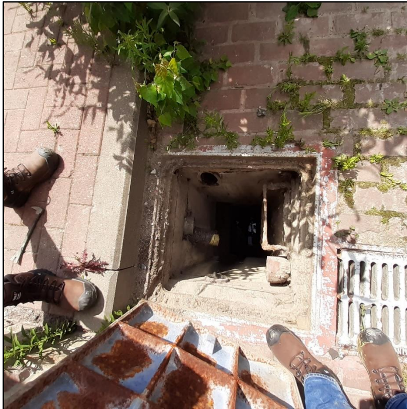
Figuur 59: Betonnen rioleringskoker ter hoogte van de huidige inrit (ABO nv 2022)
