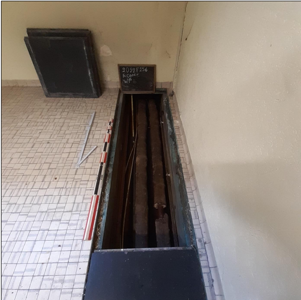
Figuur 84: Werkput 6: kruipkelder met nutsleidingen (ABO nv 2022)
