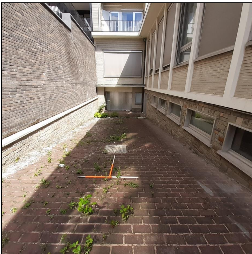
Figuur 61: Inrit met aanwezige regenwaterput (centraal) en rioleringskoker (geheel rechts) (ABO nv 2022)
