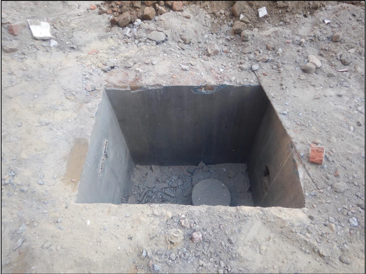
Figuur 5 Zicht op de bestaande citerne in het noordelijke deel van het plangebied.
