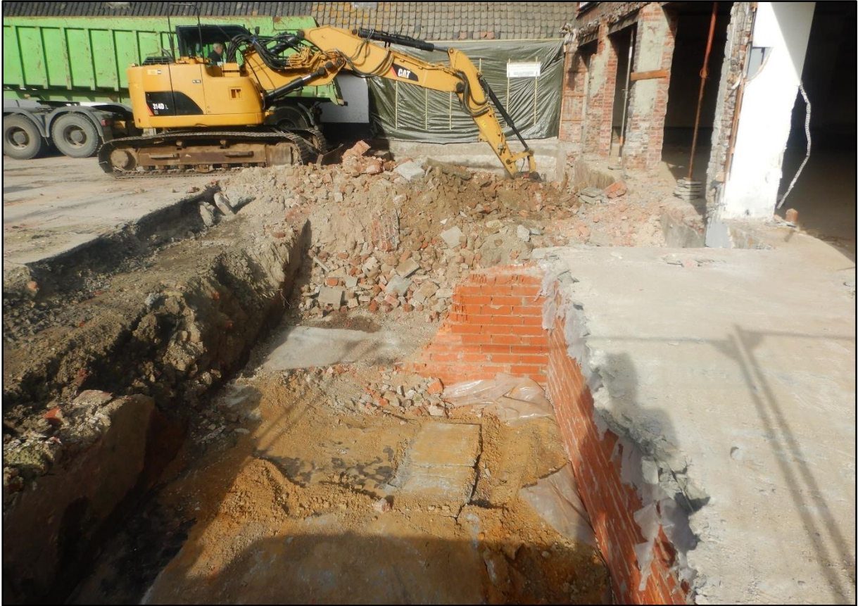
Figuur 3 Zicht op de kelders in het zuidelijke deel van het plangebied tijdens de afbraakwerken.
