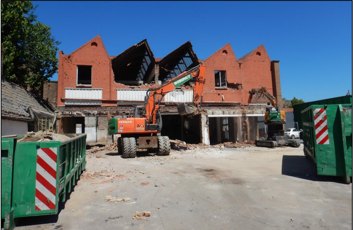
Figuur 1 Zicht op het zuidelijke deel van het plangebied tijdens de afbraakwerken.
