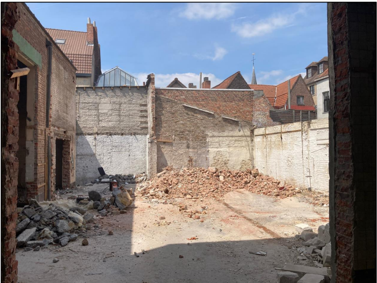
Figuur 2 Zicht op het noordelijke deel van het plangebied tijdens de afbraakwerken.
