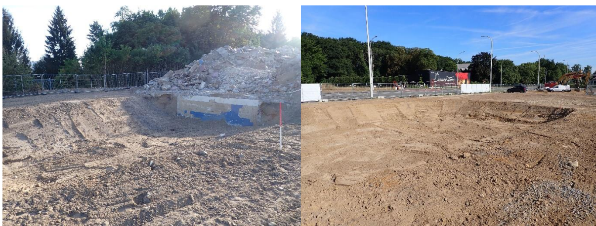
Figuur 27: Vervuilde zone (links) en uitgegraven kelder (rechts) (© J. Verrijckt Bvba)
