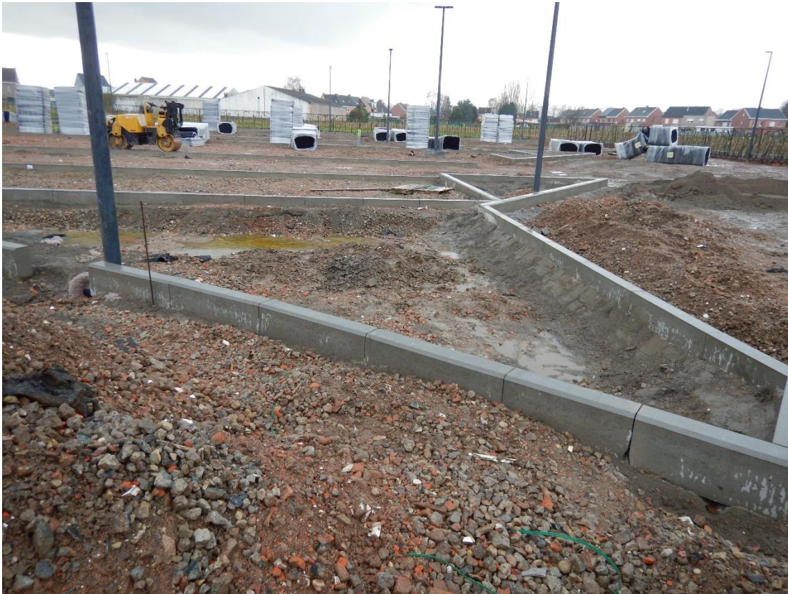
Figuur 5. Zicht op de werkzaamheden voor de aanleg van de parking ©ADEDE bvba.
