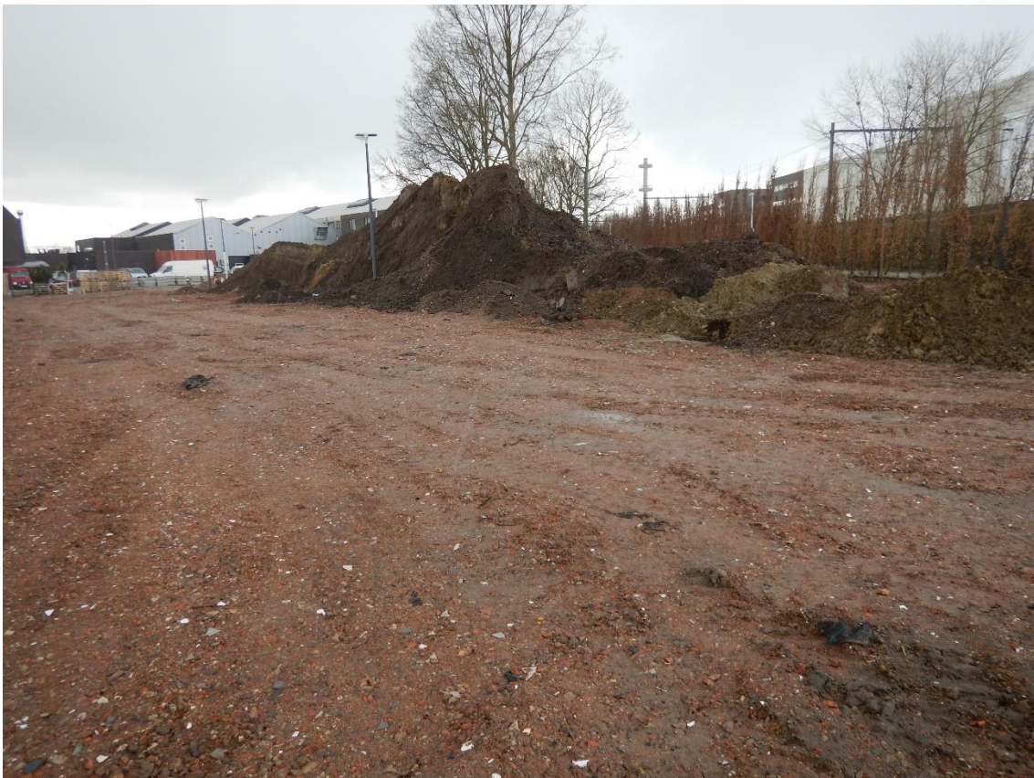
Figuur 1. Zicht op de werken ter hoogte van de aan te leggen parking ©ADEDE bvba.
