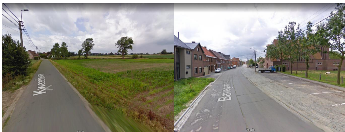
Figuur 3: Zicht vanuit het noordoosten op Kwaadbeek en het terrein voor grondverbetering (links) en zicht vanuit het noordwesten op de Bavegemstraat en locatie pompstation 1 (Google Maps, 2022)
