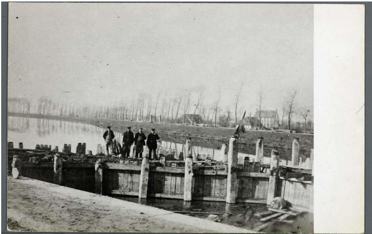
Figuur 14: Uitgraven van een afleidingskanaal aan de Houtkaai te Sint-Pieters-op-den-Dijk, Kasteel Ruddershove op de achtergrond (erfgoedbrugge.be)
