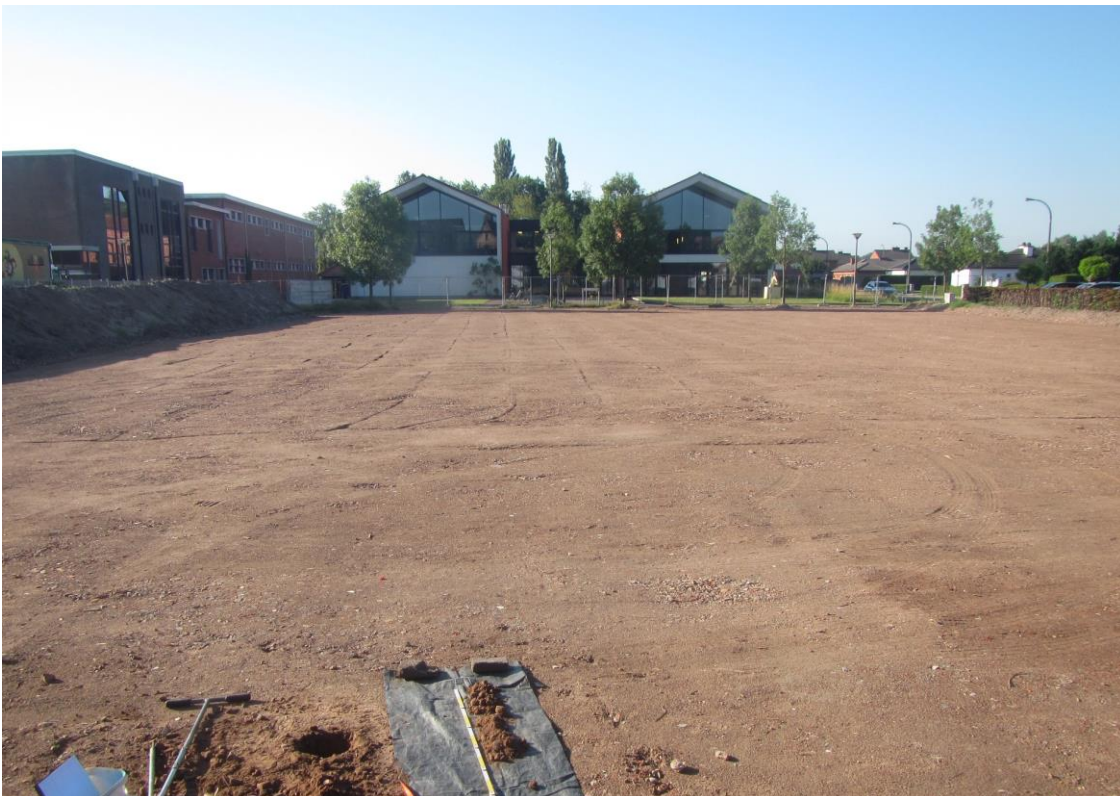
Figuur 6: Zicht op het terrein ter hoogte van BP2, kijken in zuidelijke richting.
