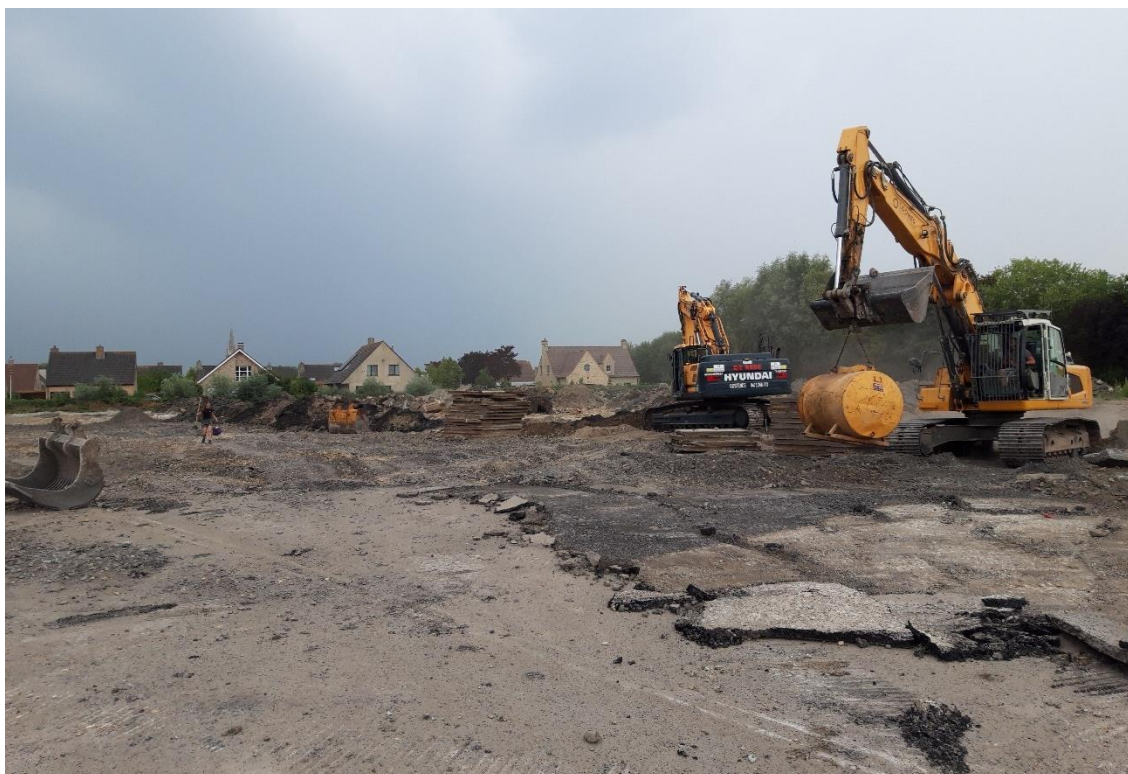
Figuur 19: Zicht op het uitbreken van de verharding.
