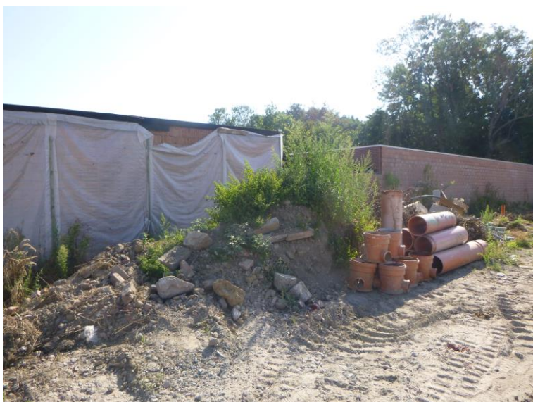
Afb. 9. De storthoop gelegen tussen werkputten 2 en 3.
