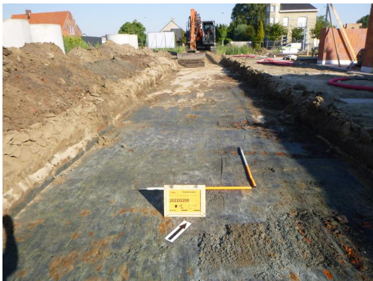
Afb. 17. Zicht op de noordelijke helft van werkput 1.
