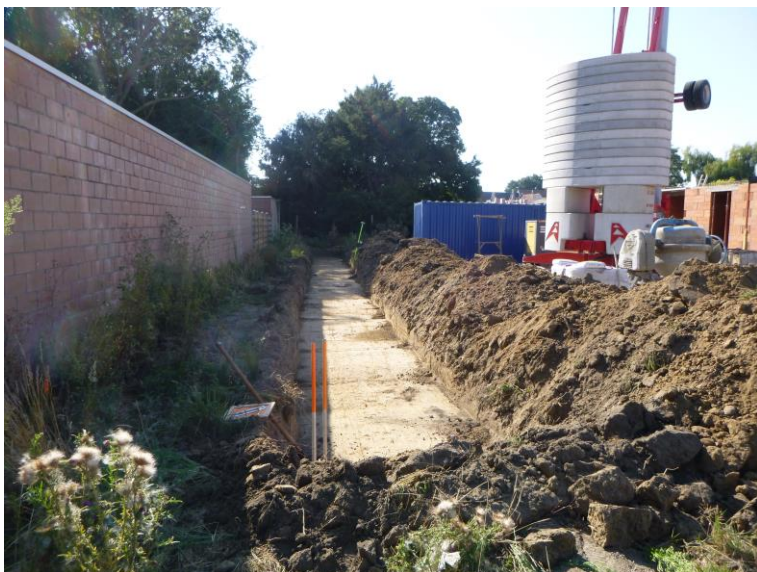
Afb. 8. Zicht op werkput 2, richting het zuiden.
