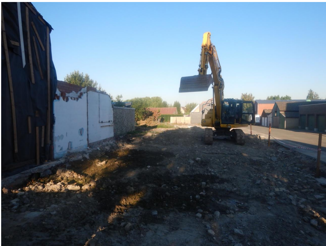
Figuur 12 Zicht vanaf de oostelijke zijde van het plangebied, voor de start van het archeologisch onderzoek.
