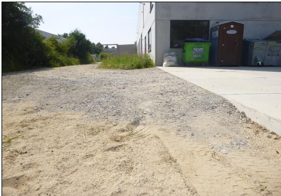
Figuur 8: De steenslagverharding ten oosten van de nieuwe loods (ABO nv 2019)
