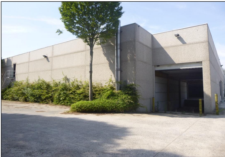
Figuur 6: De te behouden loods (ABO nv 2019)
