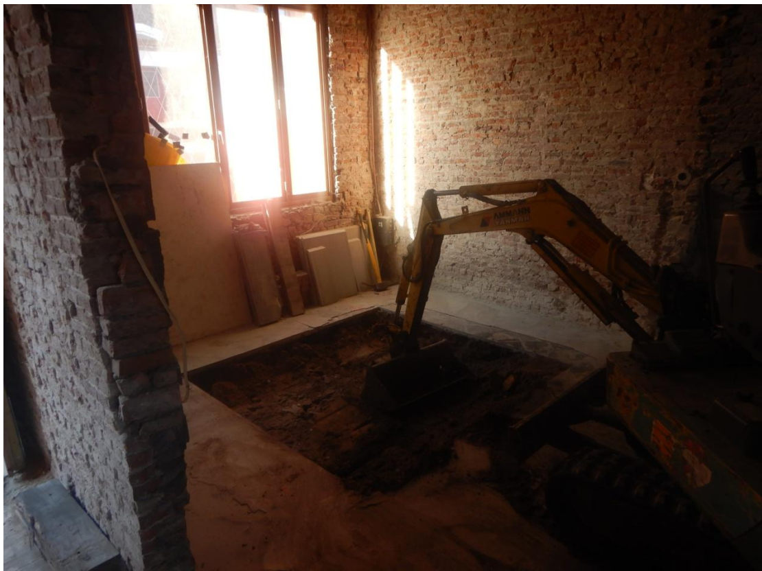
Figuur 14 Zicht op de locatie van proefput 2.
