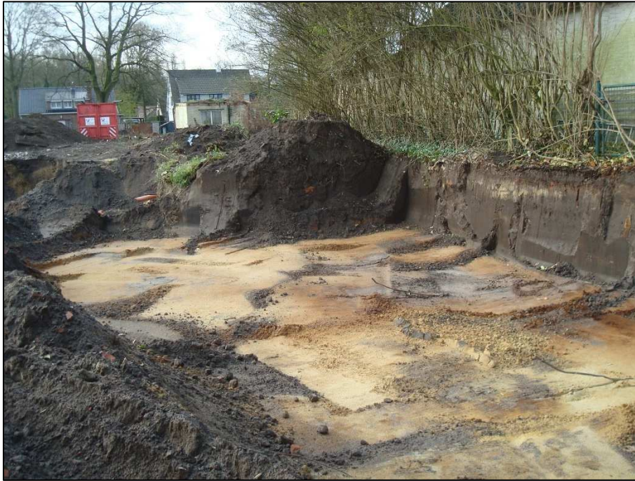
Figuur 5: Foto van uitgravingen voor de bouw van de huidige winkel (2013) 10
