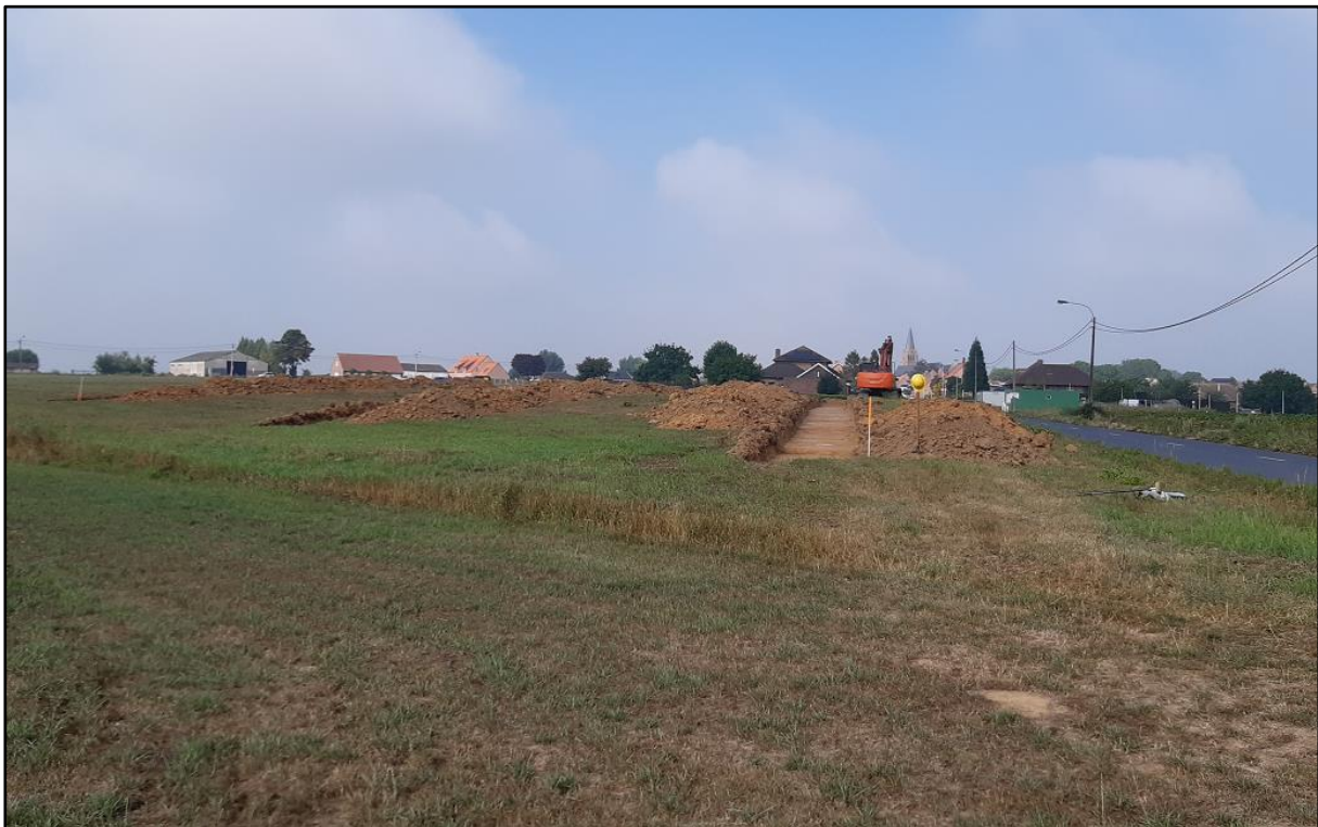
Figuur 20: Aanleg van drie proefsleuven op het terrein voor grondverbetering langs de Kruisabelestraat (ABO nv 2022).
