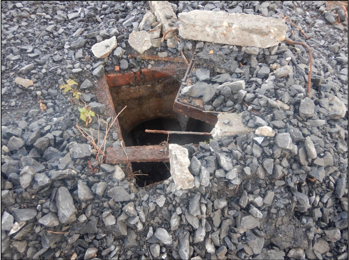
Figuur 3 Zicht op een rioolput, centraal langs de westelijke zijde van het plangebied.
