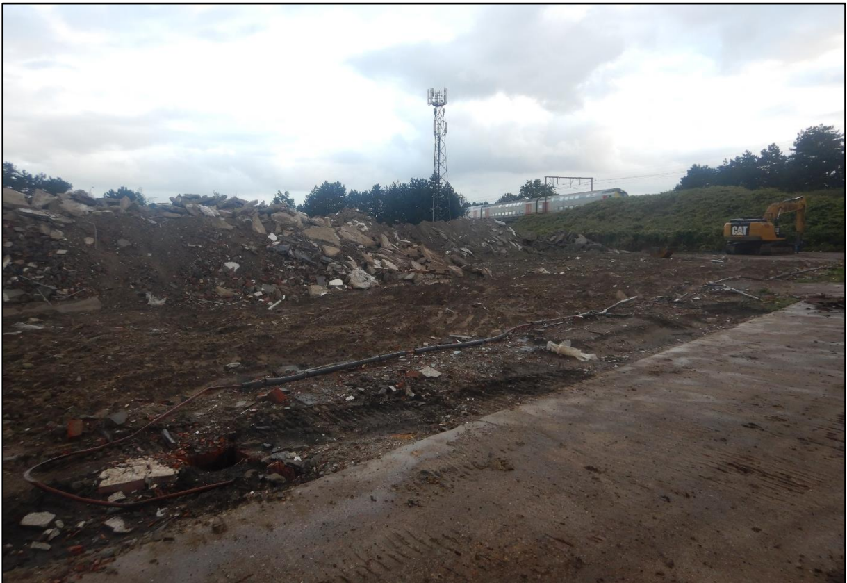
Figuur 2 Zicht op het noordoostelijke deel van het plangebied, met vooraan links een rioolput.
