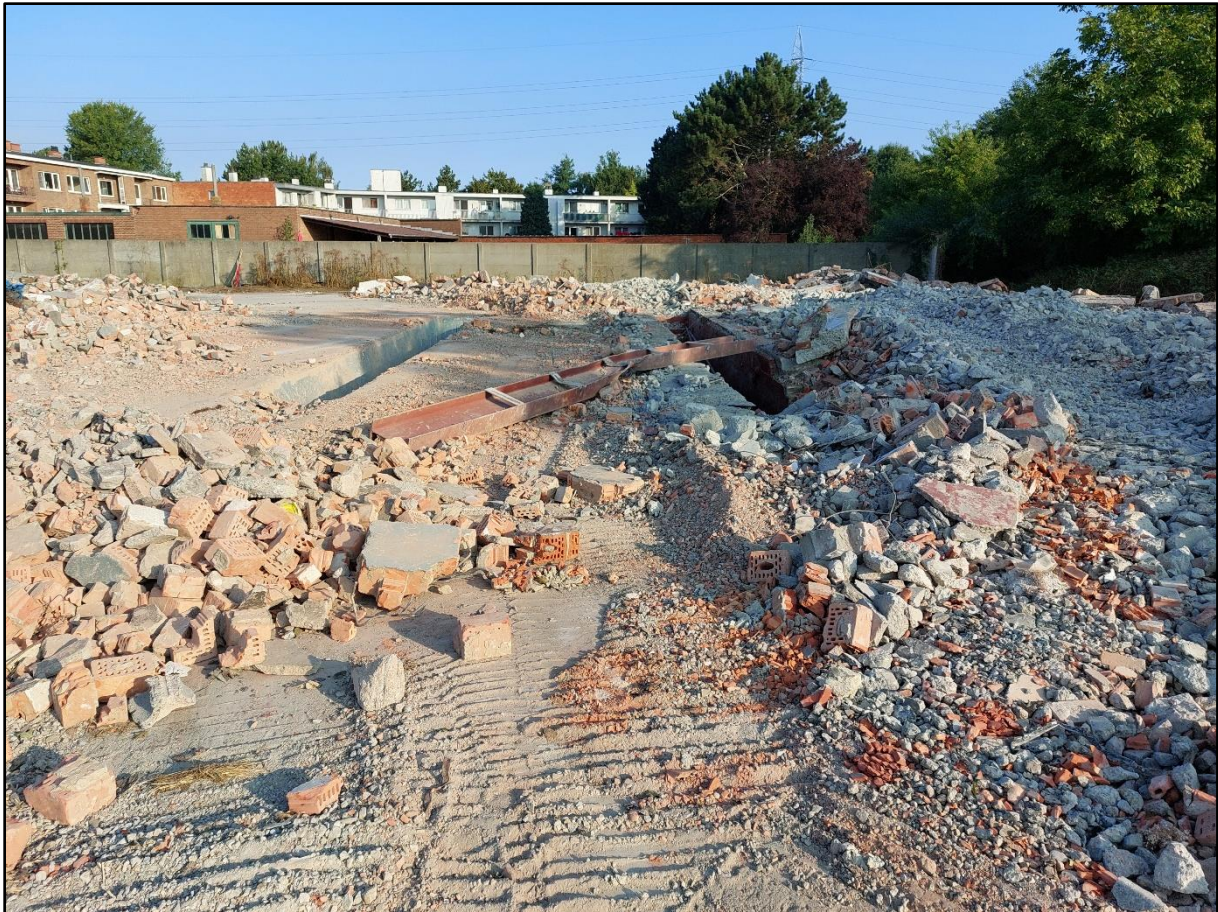
Figuur 26: Staat van het noordelijke gedeelte van het onderzoeksgebied na het opbreken van de vloerplaat (ABO nv 2022)
