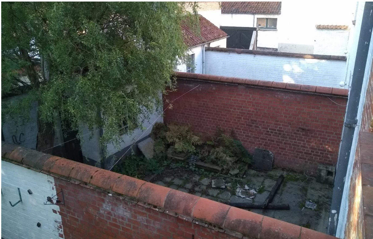
Figuur 30: Terreinopname in zuidwestelijke richting
