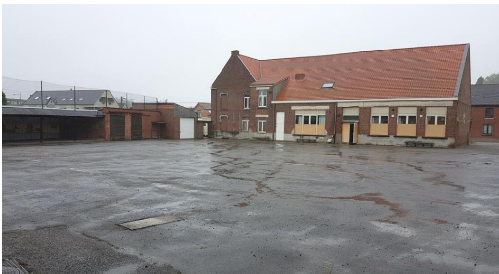
Figuur 7: Noordelijk gedeelte van het plangebied met schoolgebouw, oud gemeentehuis en geasfalteerde speelplaats
