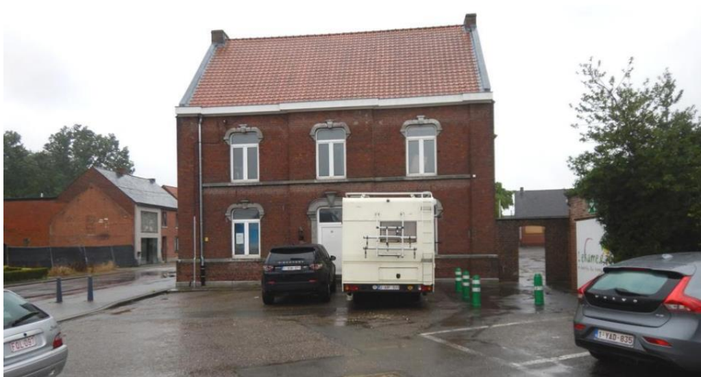
Figuur 8: Noordelijk gedeelte van het plangebied met voorgevel van oud gemeentehuis en parkeerplaats
