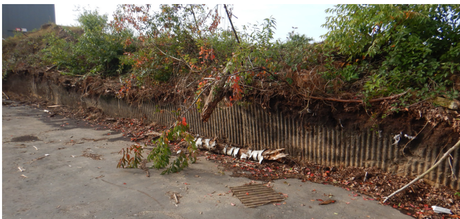
Figuur 14. Aanvulling tot circa 1 meter tegen de voormalige boogloods.
