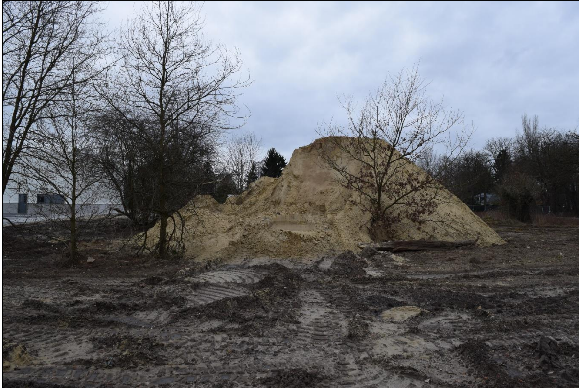
FOTO 7: Zicht op grondhoop in het zuiden van het terrein. Foto genomen vanuit het noordoosten. (Aron bvba, dd 27/02/2017, 2017B225)
