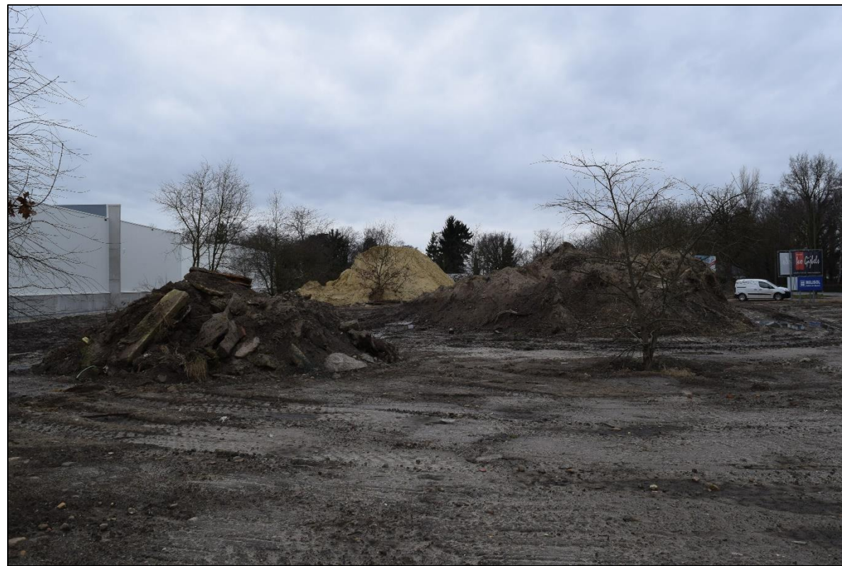
FOTO 6: Zicht op grondhopen in het zuiden van het terrein. Foto genomen vanuit het noordoosten. (Aron bvba, dd 27/02/2017, 2017B225)
