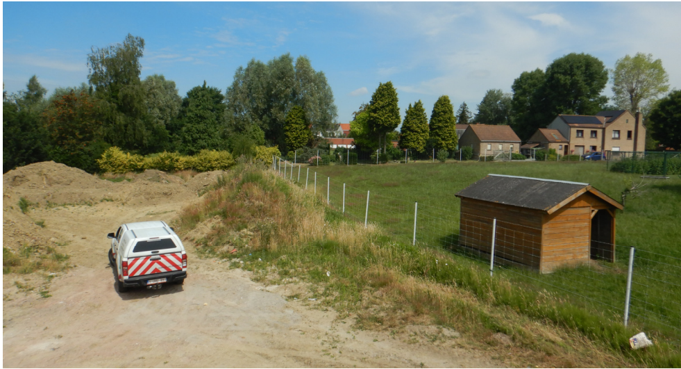
Figuur 6. Zicht op het onderzoeksgebied vanuit de werf aan de Driesstraat.
