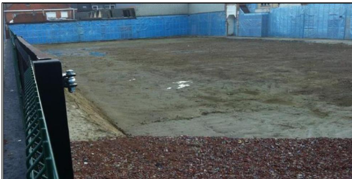
Figuur 2: De fabrieksgebouwen tijdens de sloop. Het niveau ligt beduidend dieper dan het straatniveau (Solva 2018)
