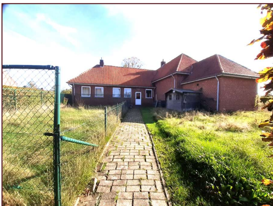
Foto 3: Schoolgebouw langs de Endstraat (W naar O)
