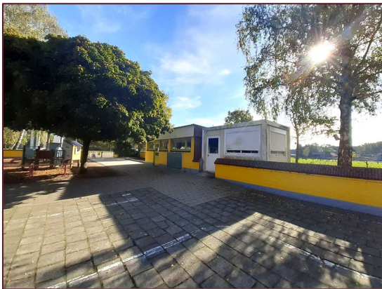
Foto 9: Speelplaats achteraan, bijgebouw, muur (W naar O)
