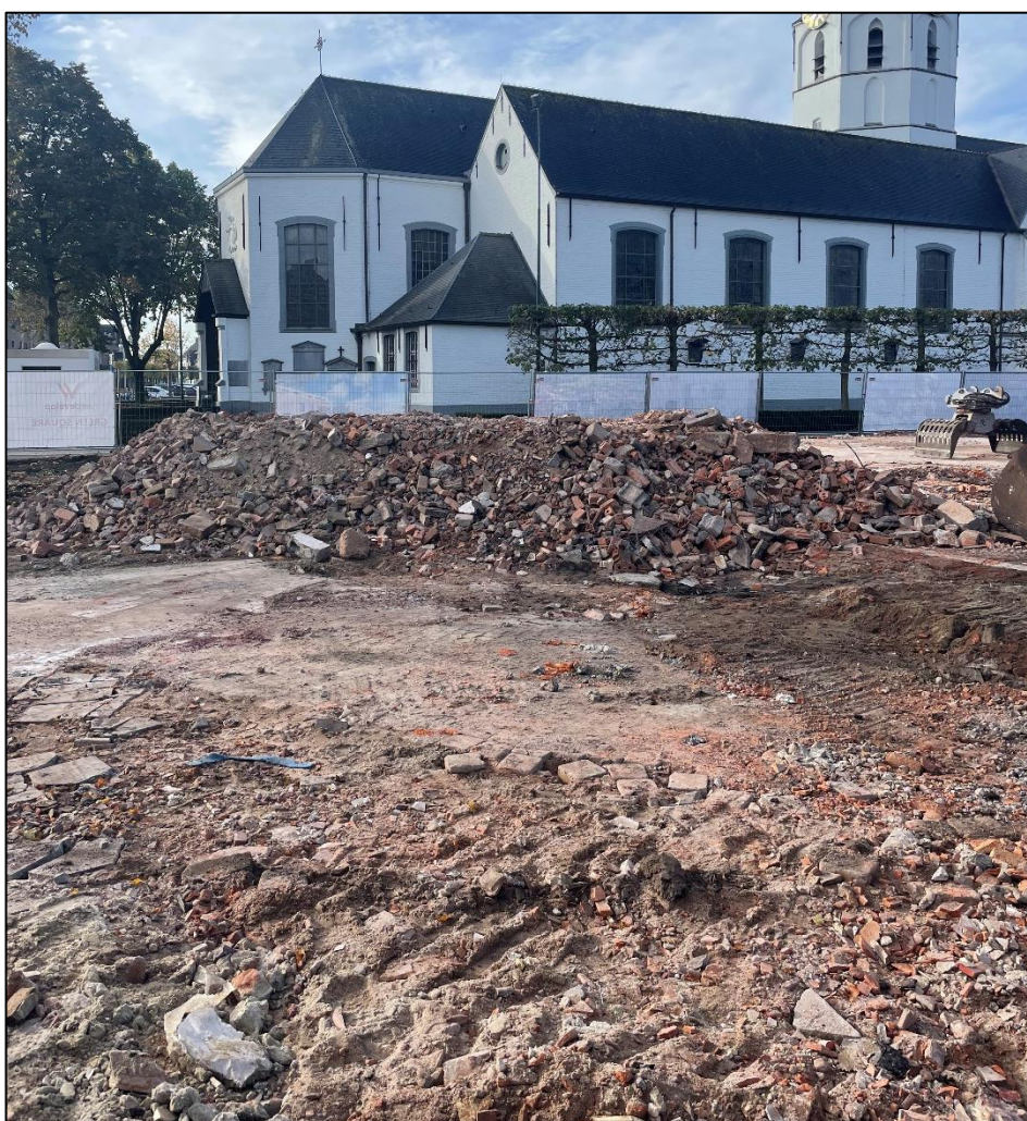
Figuur 21: Aanwezige funderingen, vloerplaten en bouwafval in het oosten van het terrein
