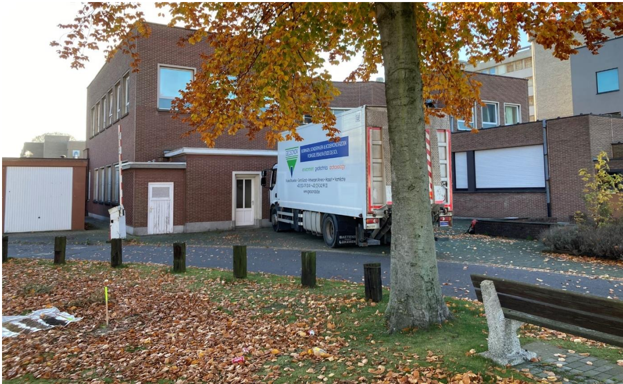
Figuur 25: Zicht op een deel van de bebouwing, ter hoogte van boring 310 (vooraan) en 301 (ter hoogte van vrachtwagen). Gefotografeerd in zuidelijke richting. (Bron: ABO 2021).
