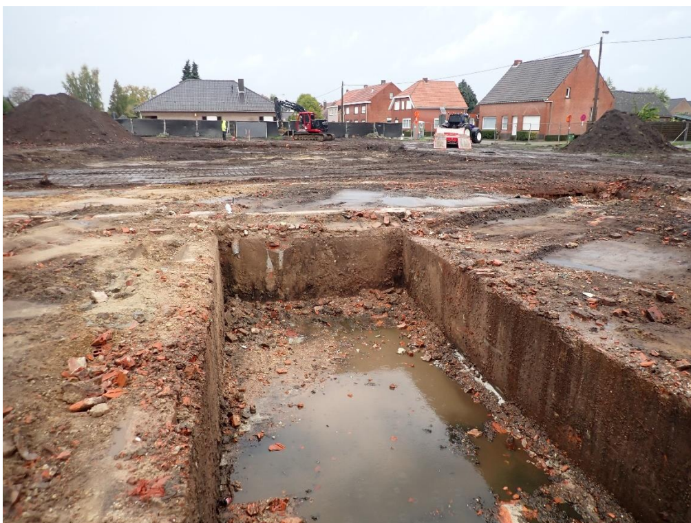
Figuur 7: Terreinfoto met zicht op één van de aanwezige kelders. Kijkrichting noord • J. Verrijckt Bvba
