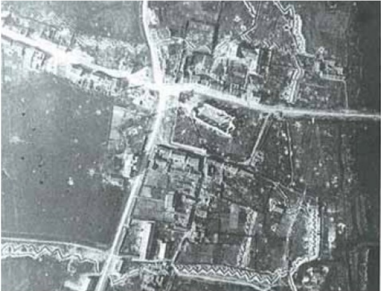
Figuur 19: Vernieling Reninge WO I: kerk met daarboven het vernielde rusthuis, rechts boerderij rondom de verdedigingslinie (Bron: COD Sint-Vincentius vzw, Hof Ten IJzer Lo-Reninge, 2009, p.19)
