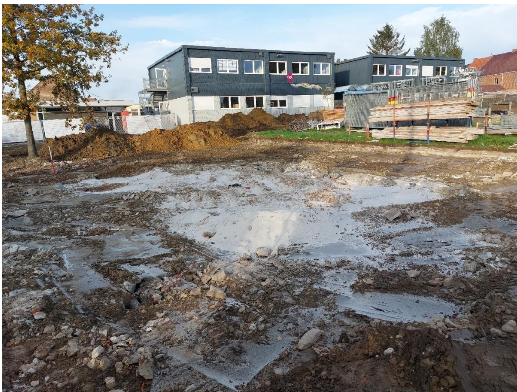
Figuur 4: Zicht op de aangetroffen kruipkelder, deze werd opgevuld met zand.
