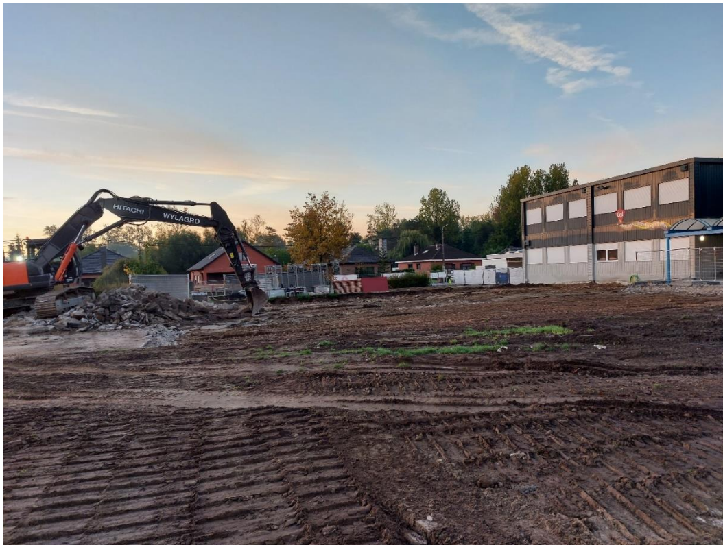
Figuur 5: Zicht op het terrein na afbraak.
