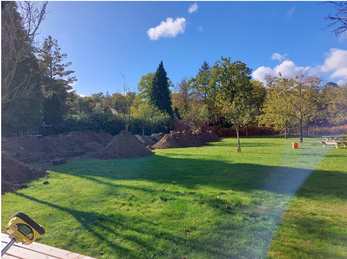
Figuur 8: Zicht op sleuf 1.
