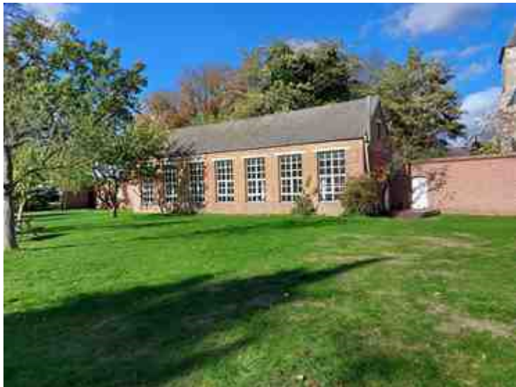
BEKA22-Terrein (5).jpg - Spoornummer(s): / - Inventarisnummer(s): / - Structuur: Algemeen 1 - Zone/Werkput/Kijkvenster/Vlak: /
