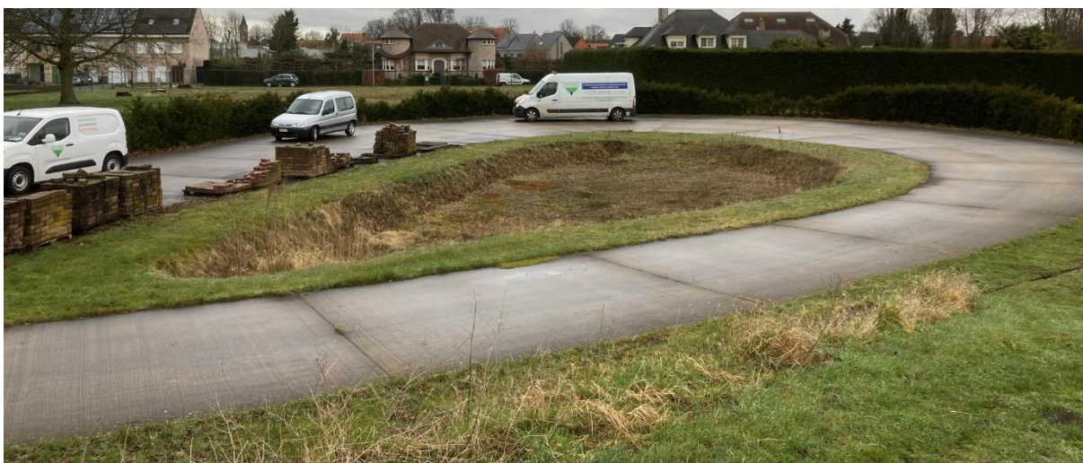
Figuur 6: Zicht op de verharde lus (LPG-laadzone) en het bufferbekken. Gefotografeerd in noordelijke richting. (Bron: ABO nv 2021).
