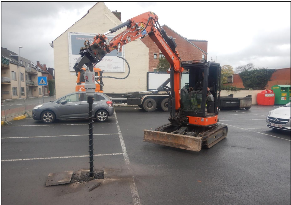
Figuur 4 Mechanische boring met avegaar van 15cm diameter.
