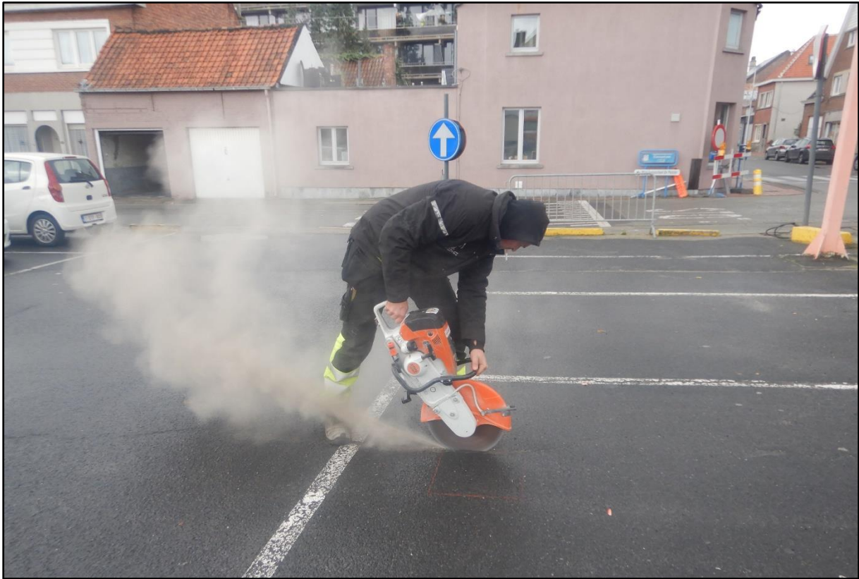
Figuur 3 Sferbeeld tijdens de voorbereiding van de mechanische boringen.
