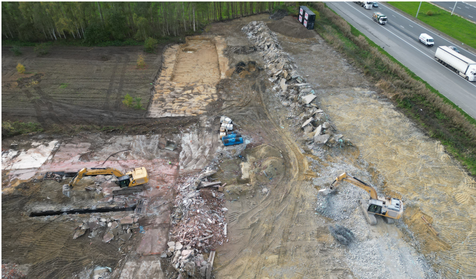
Figuur 3. Luchtfoto van de zuidelijke onderzoekszone. De centrale uitgraving op de foto is de sanering van de Japanse Duizendknoop.
