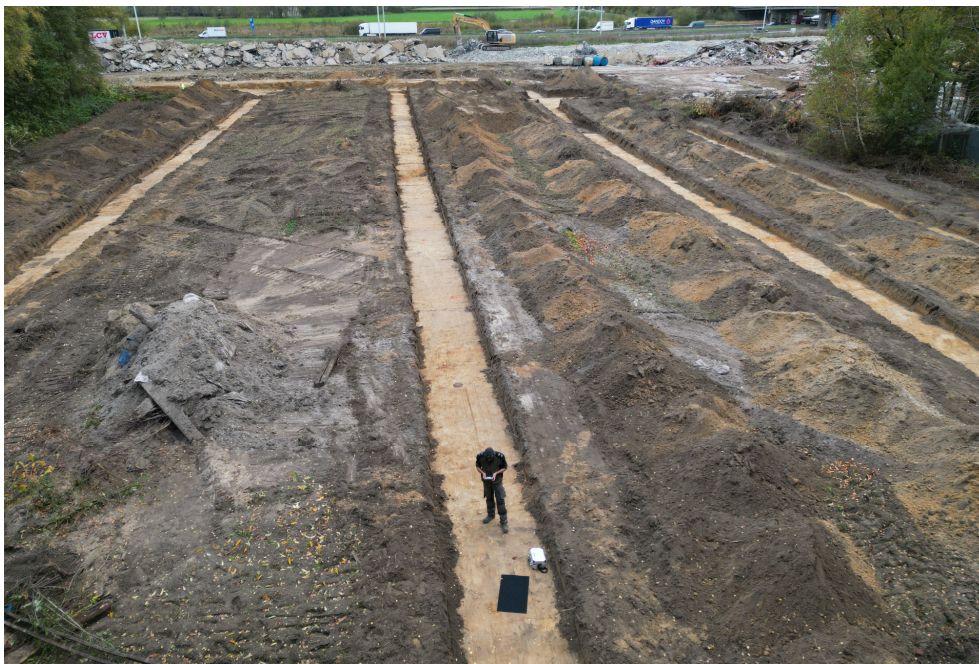
Figuur 8. Puttenplan. Onder: overzicht van de aangelegde proefsleuven in het voetbalveld.
