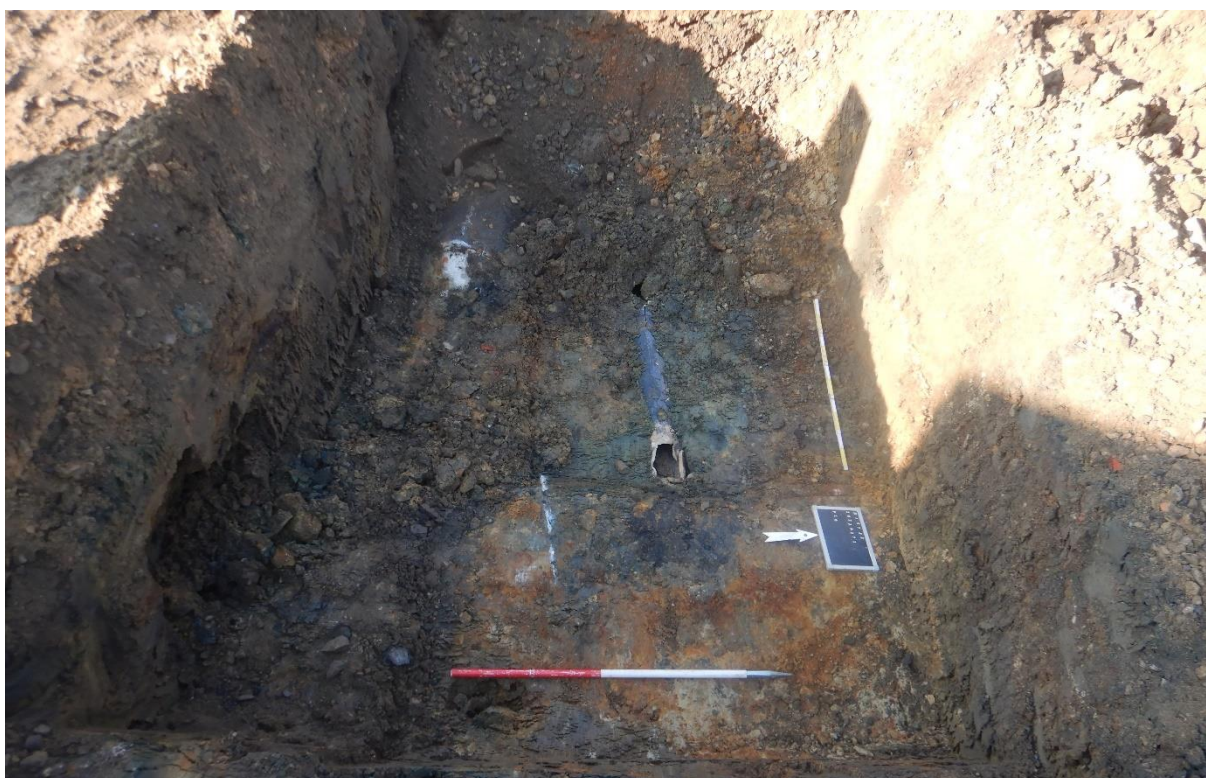
Figuur 36: Het vlak in werkput 6 met de ligging van minstens drie rioolbuizen.
