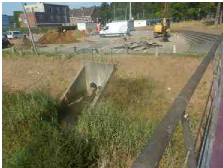
DIST22 - 2022A271 - 20220825 (39).JPG - Spoornummer(s): / - Inventarisnummer(s): / - Structuur: Algemeen 1 - Zone/Werkput/Kijkvenster/Vlak: /
