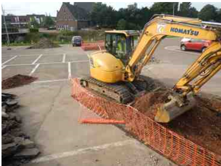
DIST22 - 2022A271 - 20220825 (5).JPG - Spoornummer(s): / - Inventarisnummer(s): / - Structuur: Algemeen 1 - Zone/Werkput/Kijkvenster/Vlak: /
