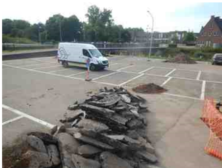
DIST22 - 2022A271 - 20220825 (4).JPG - Spoornummer(s): / - Inventarisnummer(s): / - Structuur: Algemeen 1 - Zone/Werkput/Kijkvenster/Vlak: /
