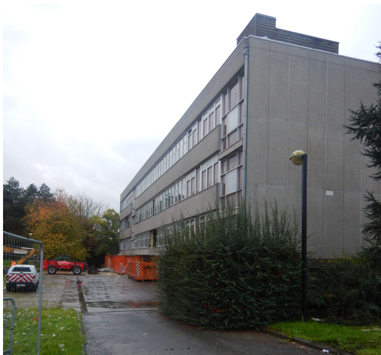
Figuur 1. Zicht op het te slopen kantoorgebouw (© Hembyse).
