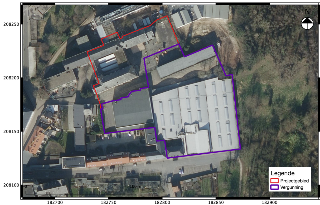
Fig. 2.2: Detail uit een luchtfoto van 2022 met aanduiding van het project- en vergunningsgebied.
