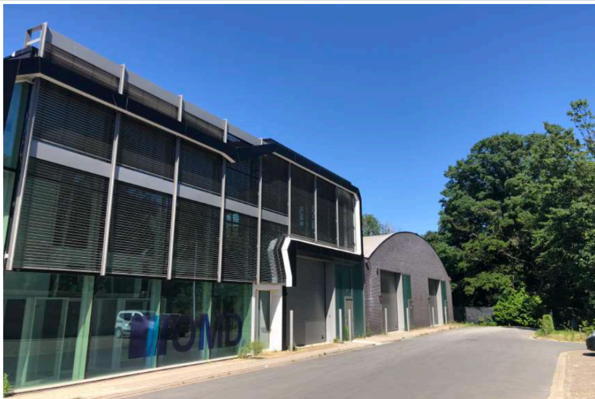
Fig. 1.8: Kantoren en loodsen Burchtstraat.
