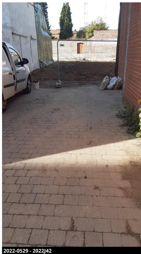
Figuur 5: Zicht op de verharding ter hoogte van de Sint-Katharinavest
