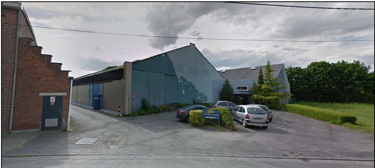
Figuur 3 Beeld vanuit het oosten op de bedrijfsgebouwen, de verharding en de elektriciteitscabine (bron: https://www.google.com/maps ).
