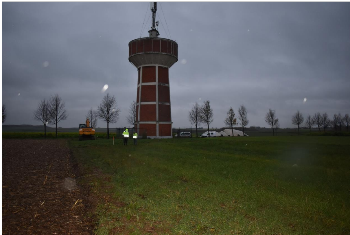
Afb. 18: Projectgebied met watertoren voorafgaand aan de aanleg van de proefsleuven.
