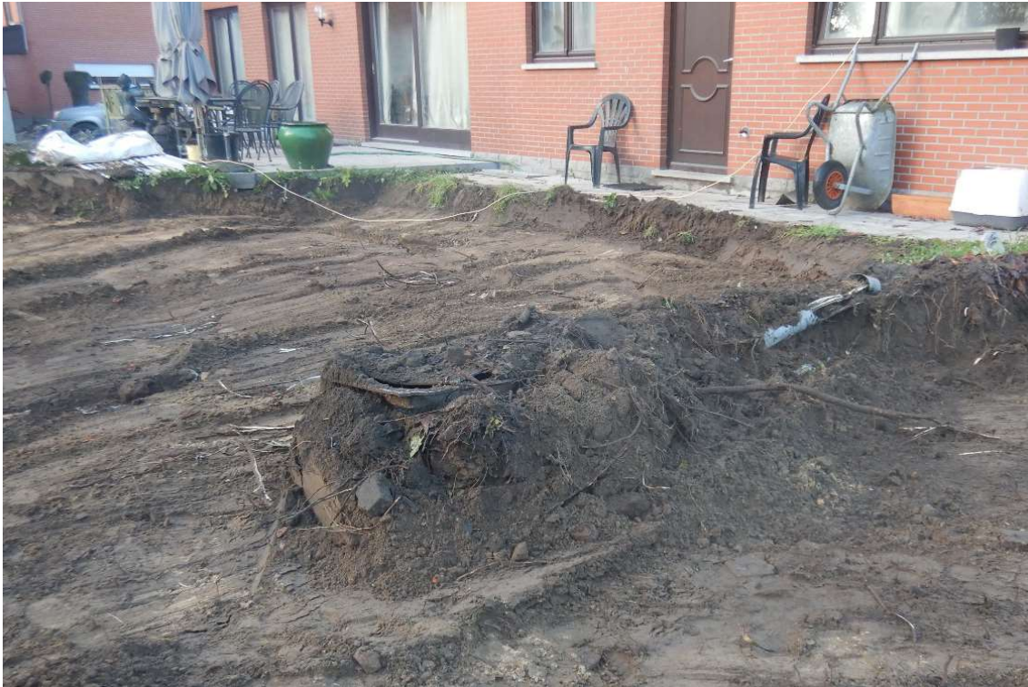
Figuur 21: Werkfoto mazouttank ter hoogte van het huis
