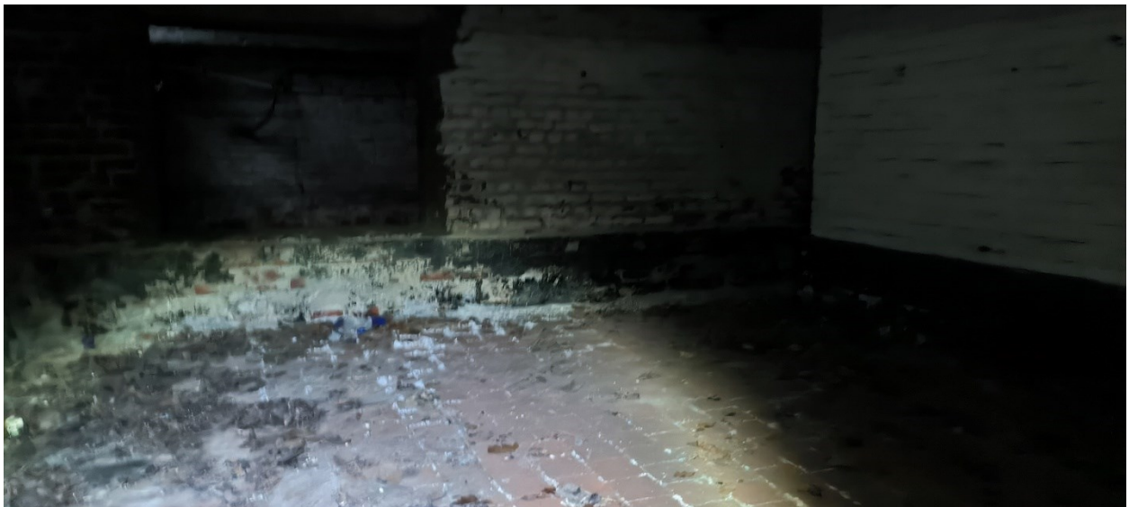
Figuur 9: Foto van een kelderruimte (ABO nv, 14/12/2022)
