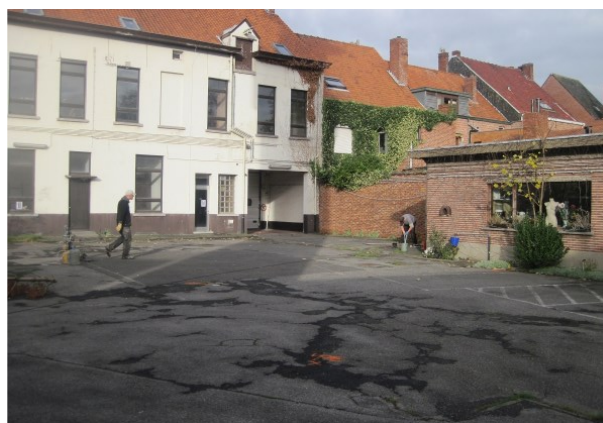
Figuur 6: Foto van burgerhuis achtergevel, lage aanbouw en deel binnenkoer (Arcadis, 2017)
