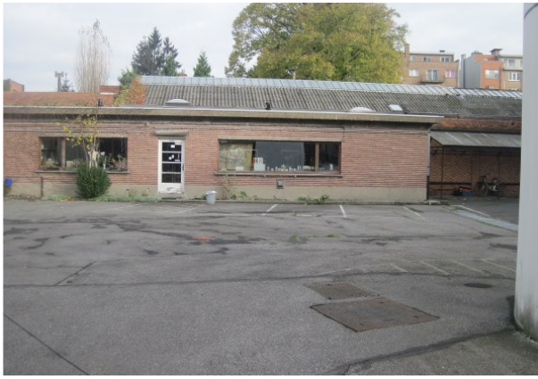
Figuur 7: Foto van de lage aanbouw in de noordelijke zone (Arcadis, 2017)
