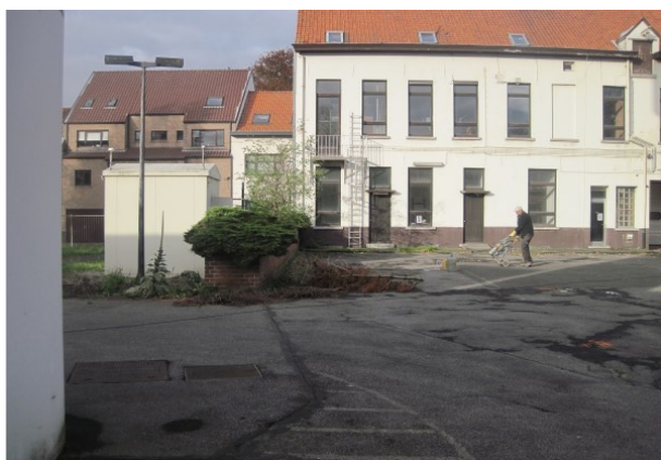
Figuur 5: Foto van burgerhuis achtergevel en deel binnenkoer (Arcadis, 2017)
